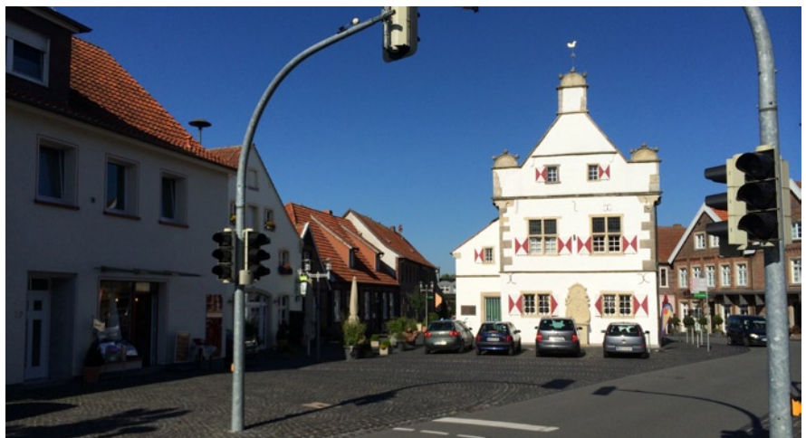
neugestalteter Ortskern: Rathausstraße mit Altem Rathaus
