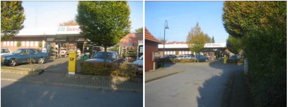
Abb. 19 : Fotos Nahversorgungsstandort Wallstrasse
