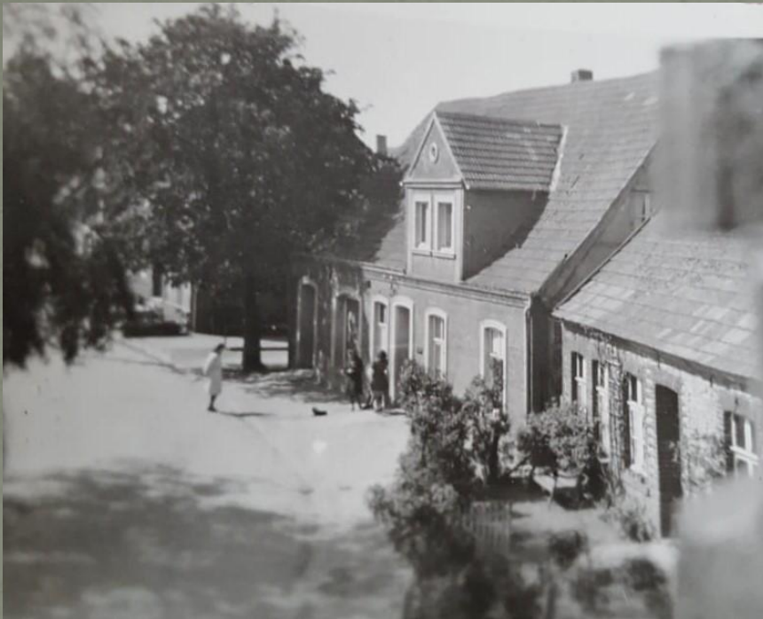
Blick auf die Nachbarhäuser in der Amtsstraße aus dem Haus Möllers heraus
