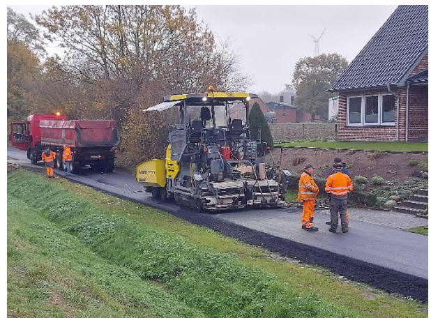
Sanierung Wirtschaftsweg bei Münstermann
