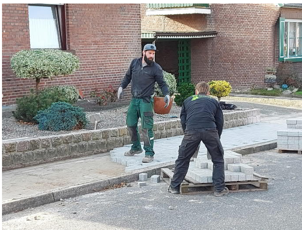
Pflasterung Berliner Straße
